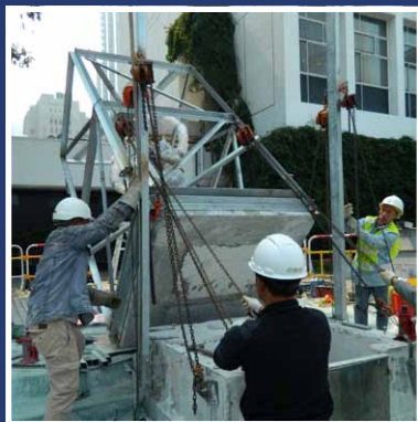
▲ 工程人员利用滑轮组件将与底座成功分离的「缘的交往」置于合适位置
