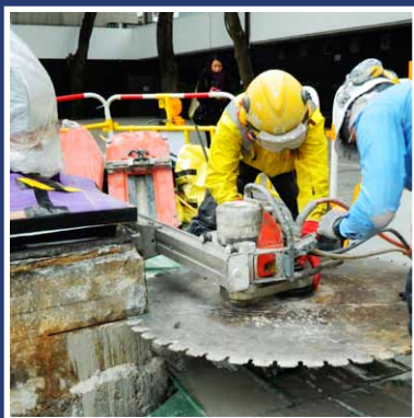
▲ 工程人员为水泥切割工序作最后准备
